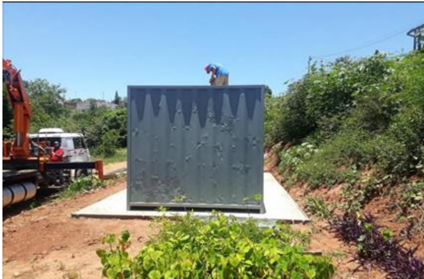
Figura 33: Vista do container sendo instalado em área da prefeitura
