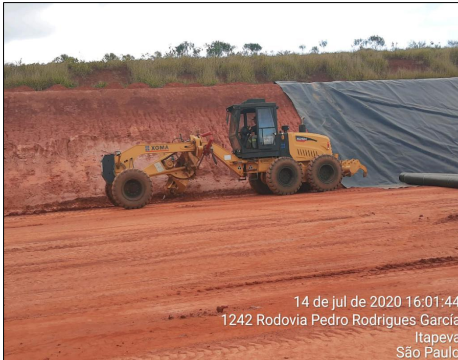
Figura 14: Aterro municipal em fase final de construção.
