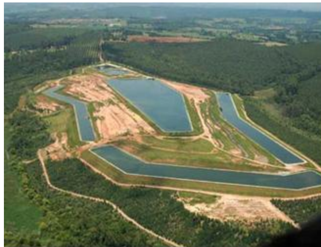
Figura 39: Vista do alto ETE de Itapeva.
