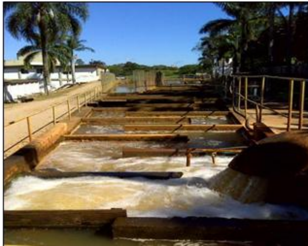
Figura 38: Vista da chegada da água bruta na ETA Pilão D'Água
