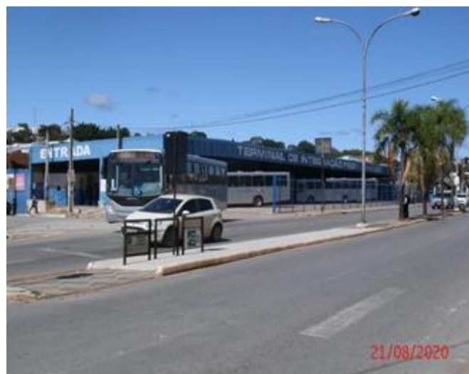
Figura 31: Vista do Terminal Urbano de Itapeva
