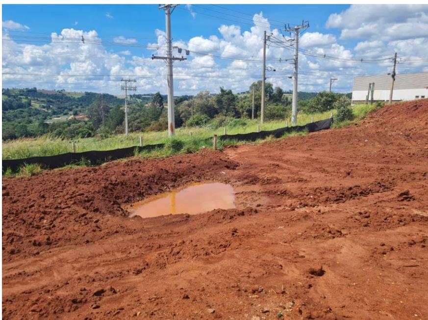
Figura 22 – Vista da movimentação de terra em área com presença de sistemas de contenção de sólidos (paliçada e sump de retenção de água)
