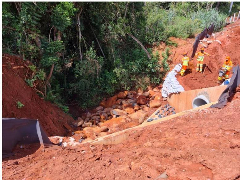
Figura 20 – Vista do ponto de proteção em enrocamento lançado na área de nascente
