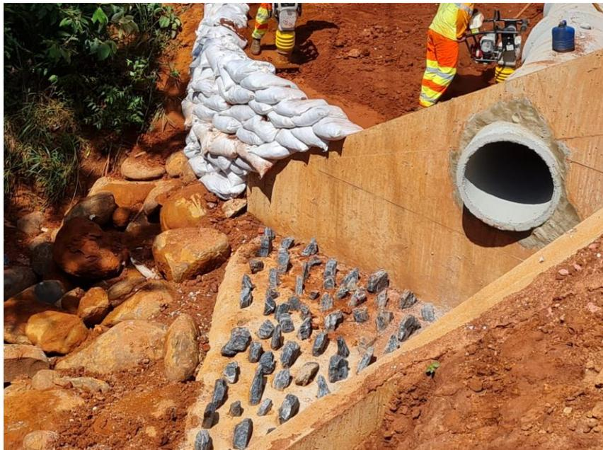
Figura 18 – Vista do ponto de lançamento da travessia sob a SP-258, e conexão hidráulica com os lançamentos adjacentes de drenagem
