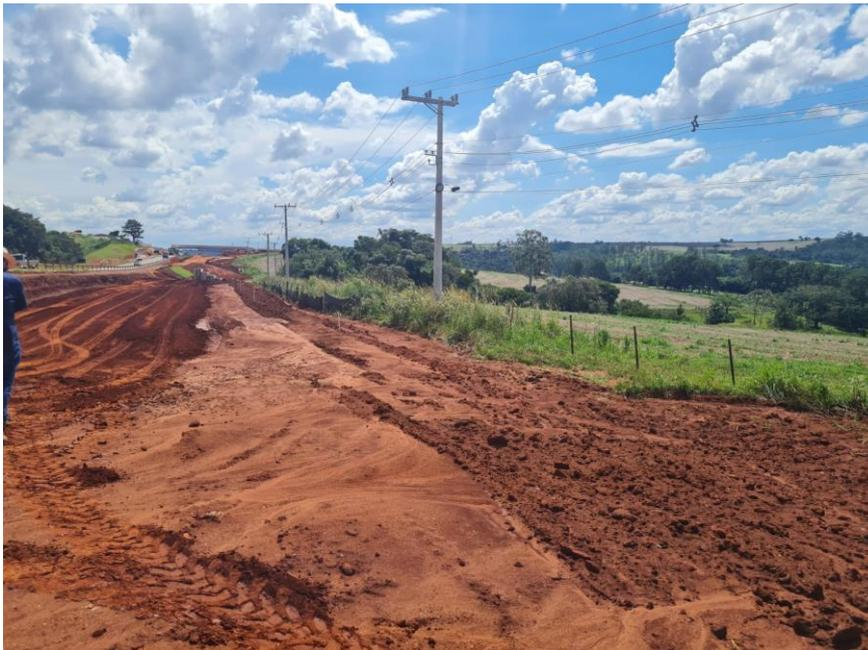
Figura 21 – Vista da movimentação de terra em área com susceptibilidade à carreamento para o córrego em estudo
