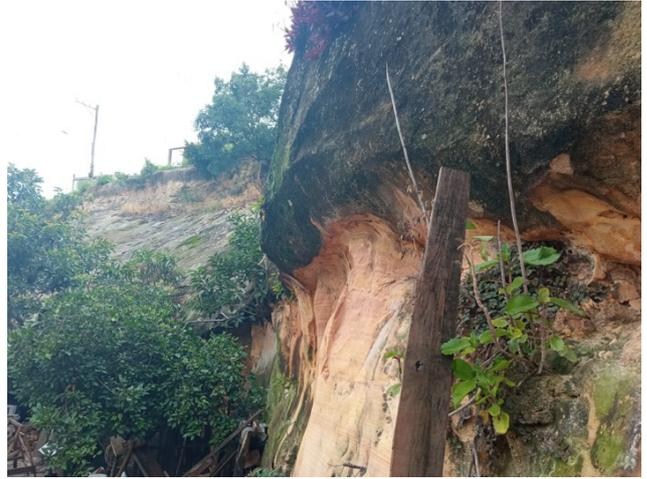
**Foto VII.b.2 – Detalhe da erosão preferencial de camada inferior em maciço rochoso.**
