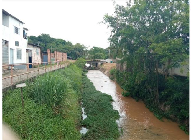
**Foto VI.b.2 – Leito do córrego apresentando sinais de assoreamento e acúmulos de detrito.**
