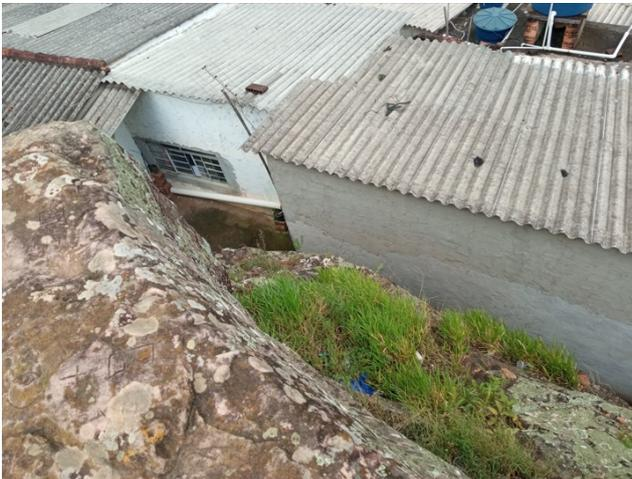
**Foto VI.b.3 – Trecho onde o maciço de rochoso direciona o fluxo de água diretamente para edificações à jusante.**
