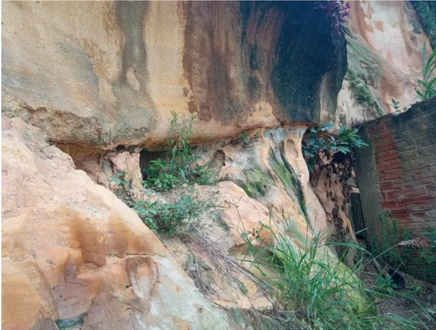
**Foto VII.b.1 – Construção logo abaixo de área onde o maciço apresenta camada argiloarenosa com processo erosivo.**
