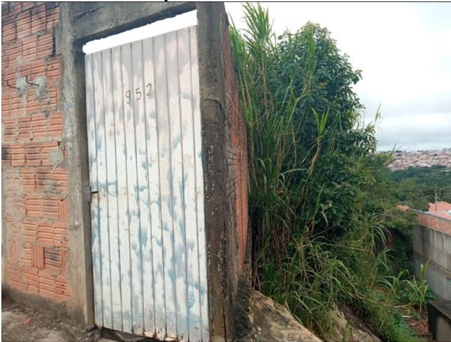
**Foto VII.b.3 – Muro construído junto ao topo de encosta. A estrutura está pendendo levemente para o lado do talude.**
