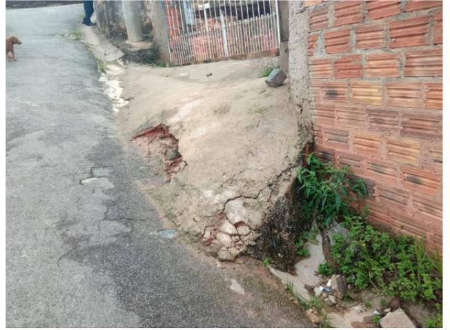
**Foto VI.a.2 – Piso de cimento fraturado devido à drenagem deficiente.**
