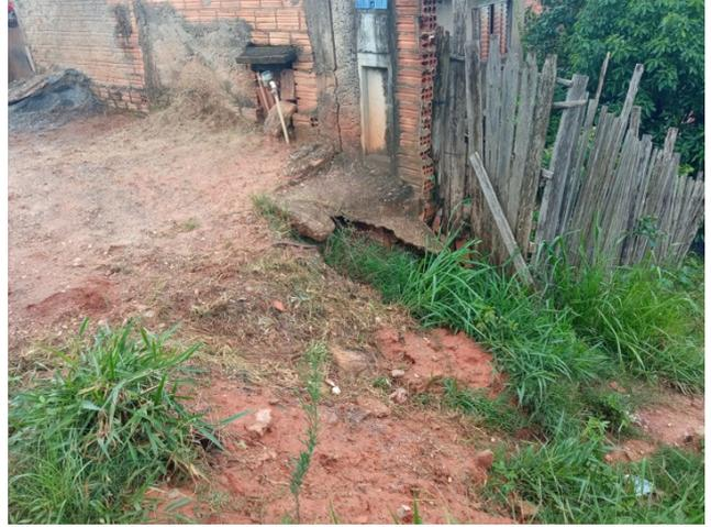
**Foto VII.b.4 – Contenção precária de concreto suspensa pela erosão do solo abaixo dela.**
