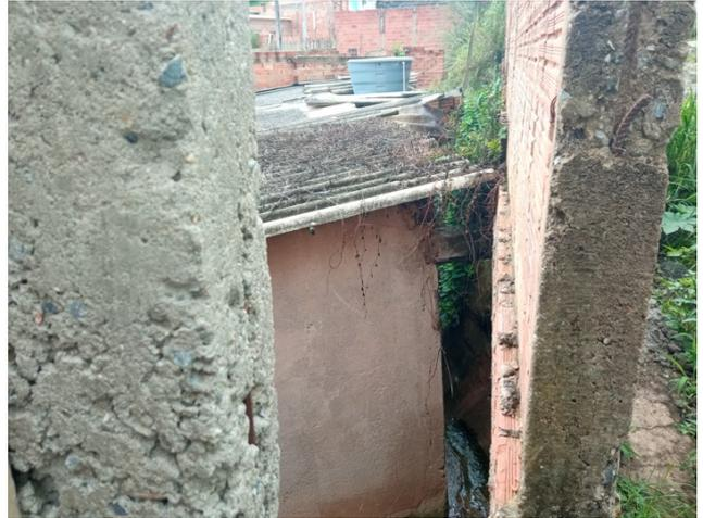
**Foto VII.b.6 – Talude de aproximadamente 3 m e 60° com topo ocupado por viela com cimento precário e base ocupada por residências.**
