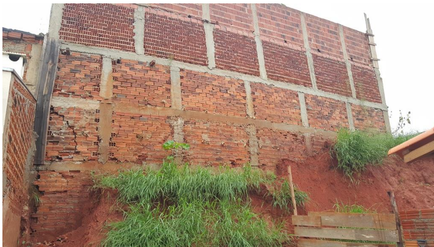
Muro de Arrimo
