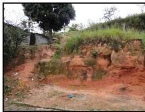
Detalhe do maciço rochoso alterado e inclinado.
