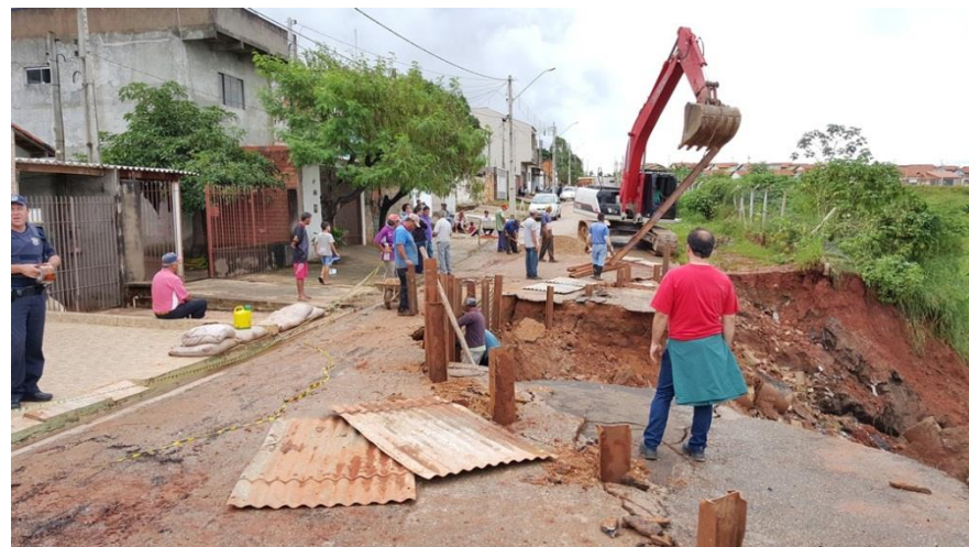
Contenção do Deslizamento
