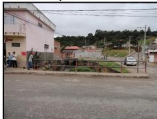
Vista do trecho canalizado no córrego Aranha.
