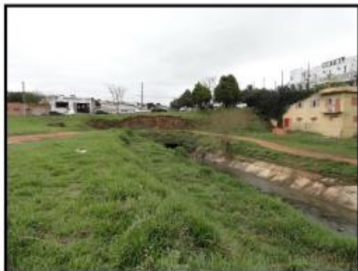
Vista geral da área IPV-03. Notar tubo de concreto na passagem sob a rua, responsável pelo refluxo das águas do córrego Aranha.
