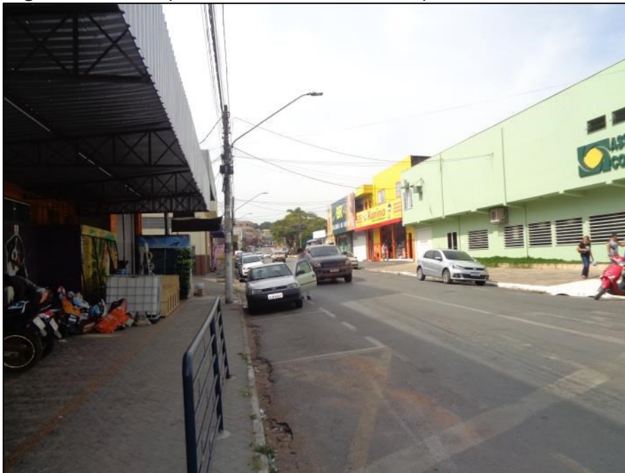
Figura 24 – Vista parcial do setor. Notar a via pavimentada.
