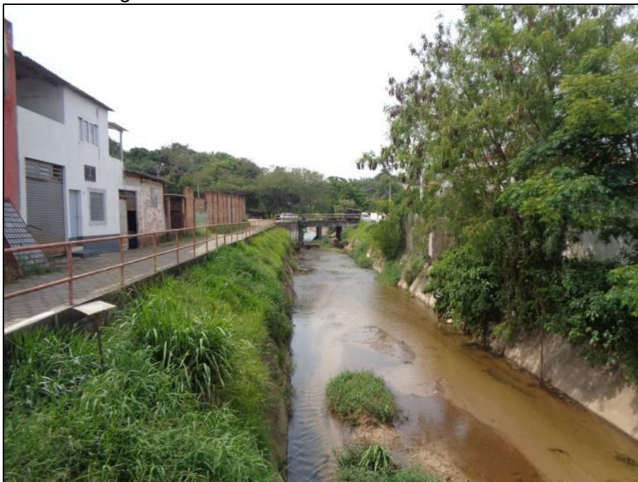
Figura 34 – Vista do córrego Aranha. Notar as margens vegetadas e o talude marginal concretado
