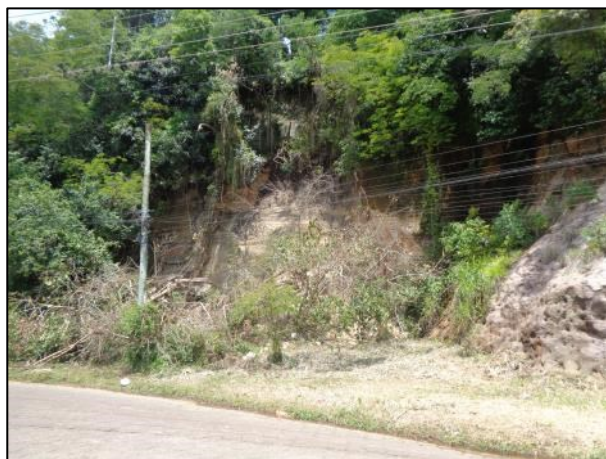
Foto 8 – Detalhe do material depositado n base do talude rochoso, composto por arvores e blocos de rocha.
