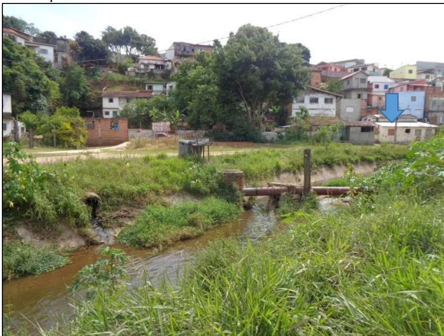
Figura 33 – Vista parcial do setor. A seta azul indica as moradias desocupadas.
