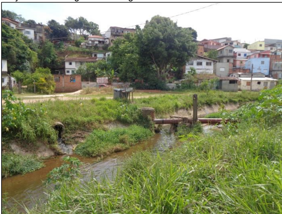
Figura 35 – Ponto de travessia de tubulação de esgoto e de lançamento de esgoto no córrego.
