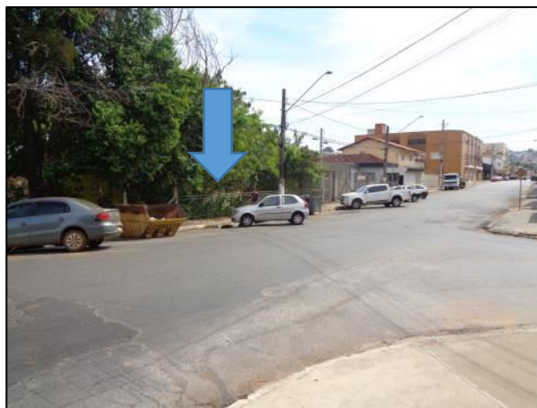
Foto 2 – Vista parcial do setor. A seta azul indica o ponto onde o córrego Lageadinho passa a céu aberto..
