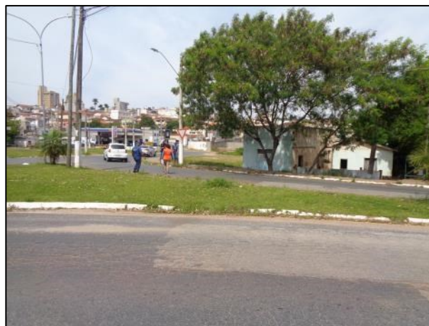
Foto 10 – Vista de moradia afetada pelo extravasamento do córrego Aranha.
