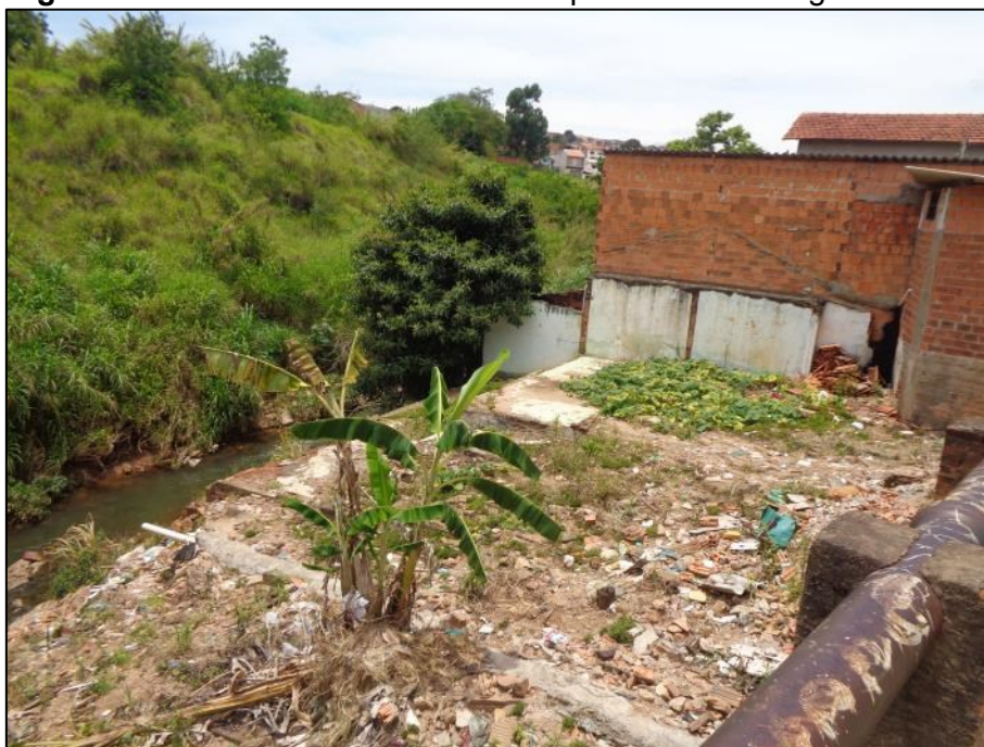
Figura 44 – Moradias construídas no topo do talude marginal.
