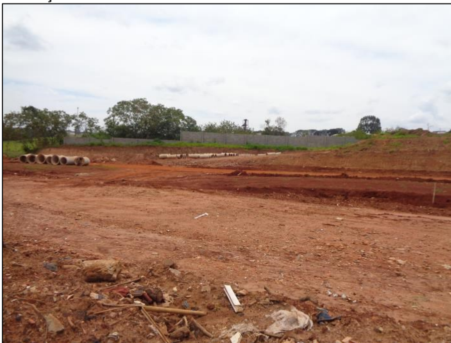
Figura 20 – Antiga área IPV-01. Moradias foram removidas para realização de Avenida.
