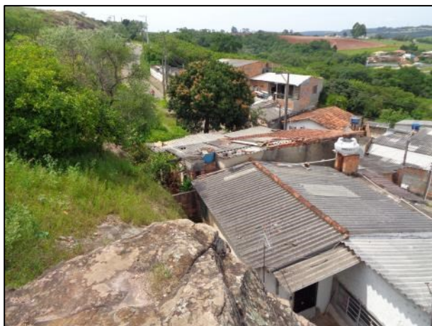
Foto 13 – Vista parcial do setor. Notar o padrão construtivo das moradias.
