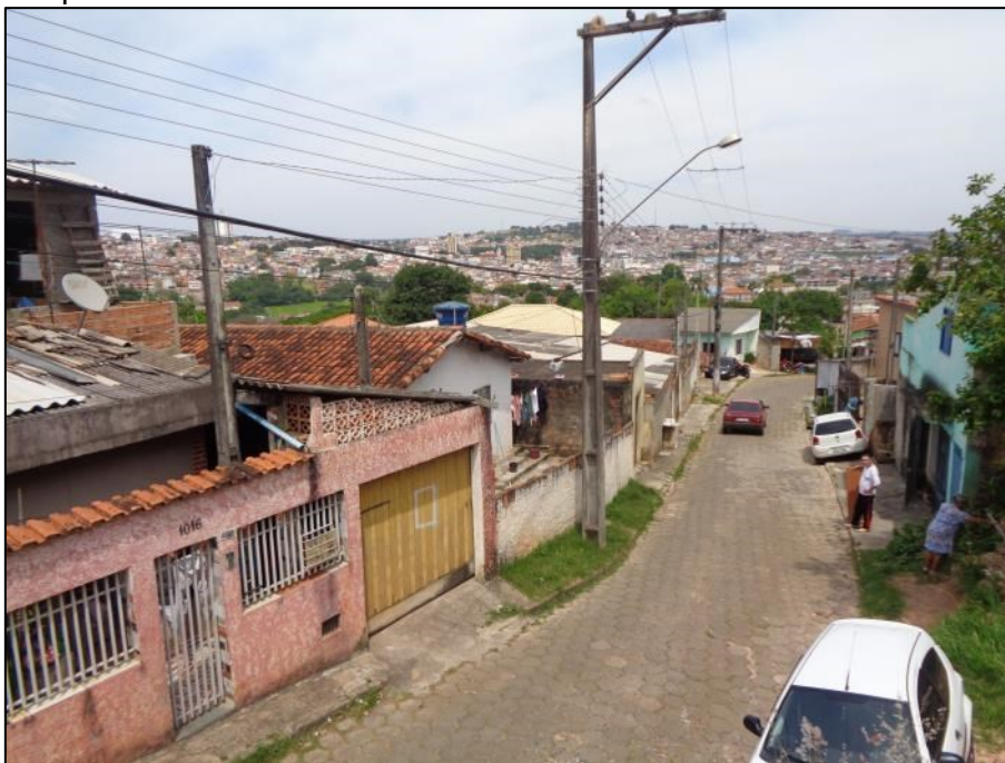
Figura 37 – Vista parcial da área. Notar a via pavimentada com bloquete.
