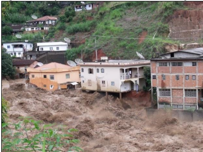
Figura 8 - Situação de enchente em um canal de drenagem.
