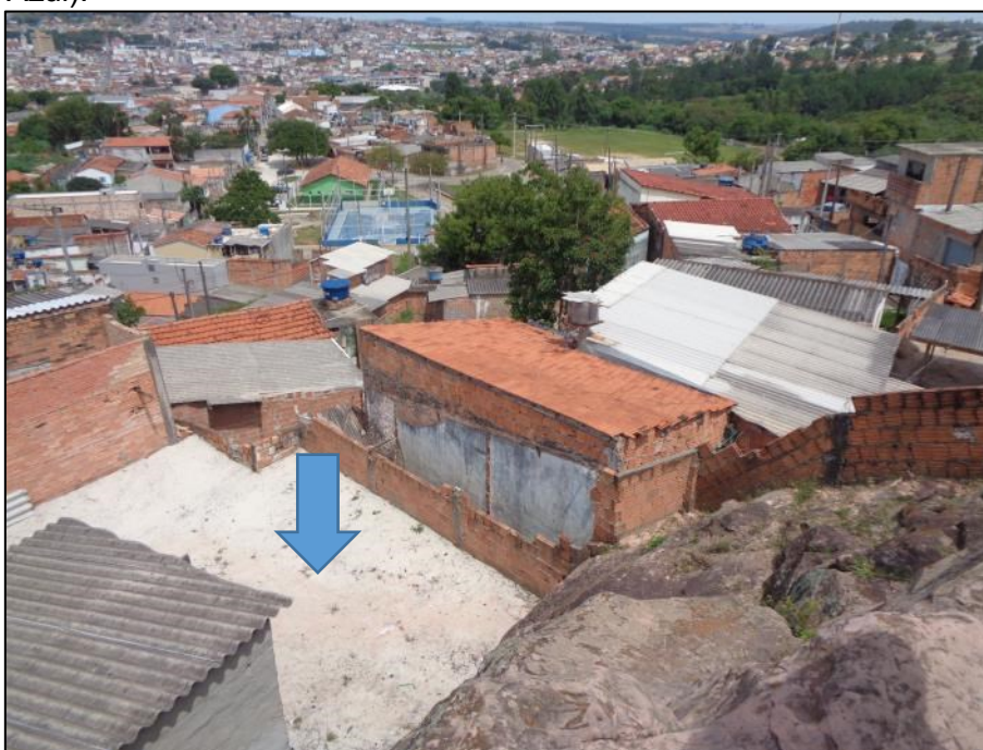
Figura 40 – Moradia afetada por fluxo de água superficial (Seta Azul).
