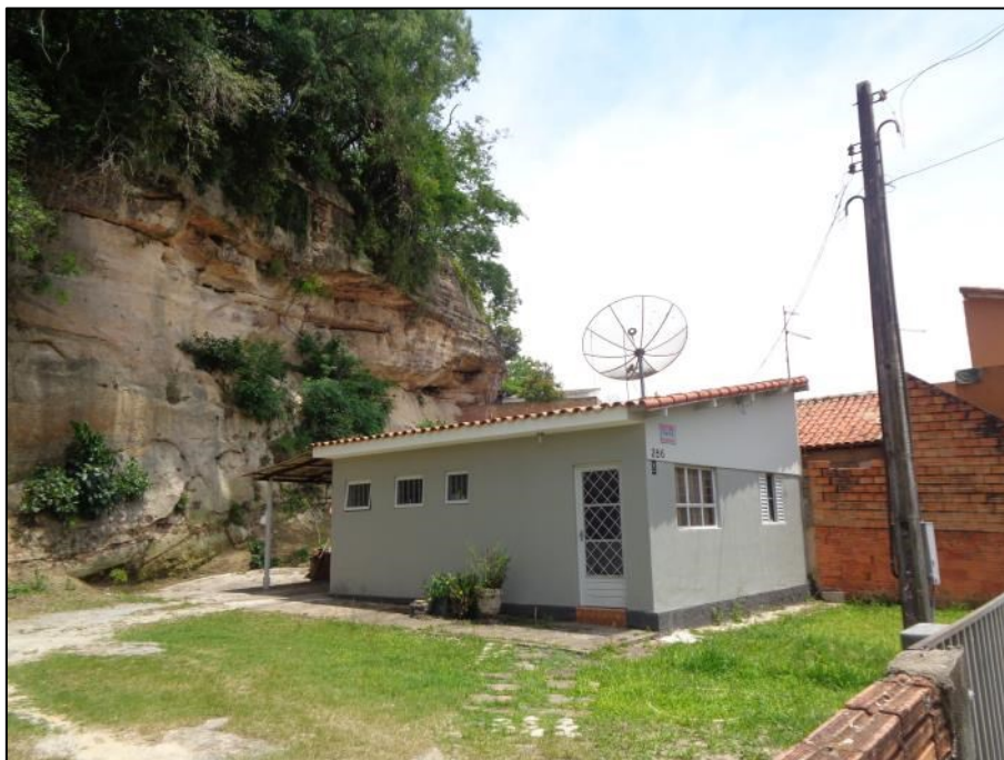
Figura 29 – Notar a distância da moradia ao talude e o padrão construtivo.
