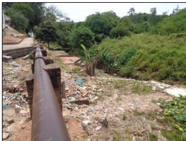
Foto 20 – Porção final do setor onde moradias foram demolidas e os moradores realocados.
