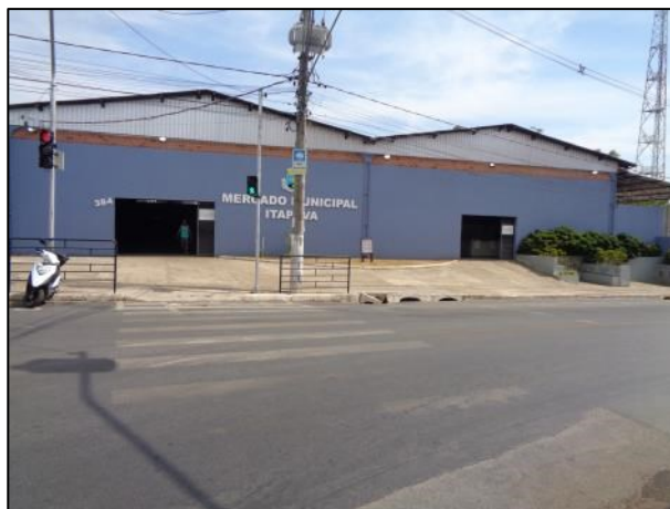
Foto 4 – Notar o sistema de drenagem superficial ao lado do Mercado Municipal.
