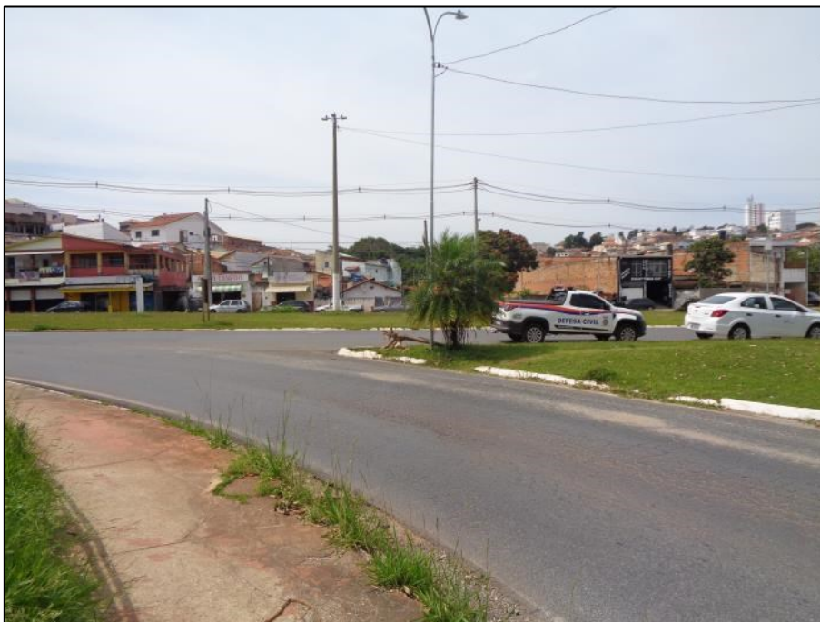
Figura 32 – Vista parcial do setor. Notar o padrão construtivo das moradias.
