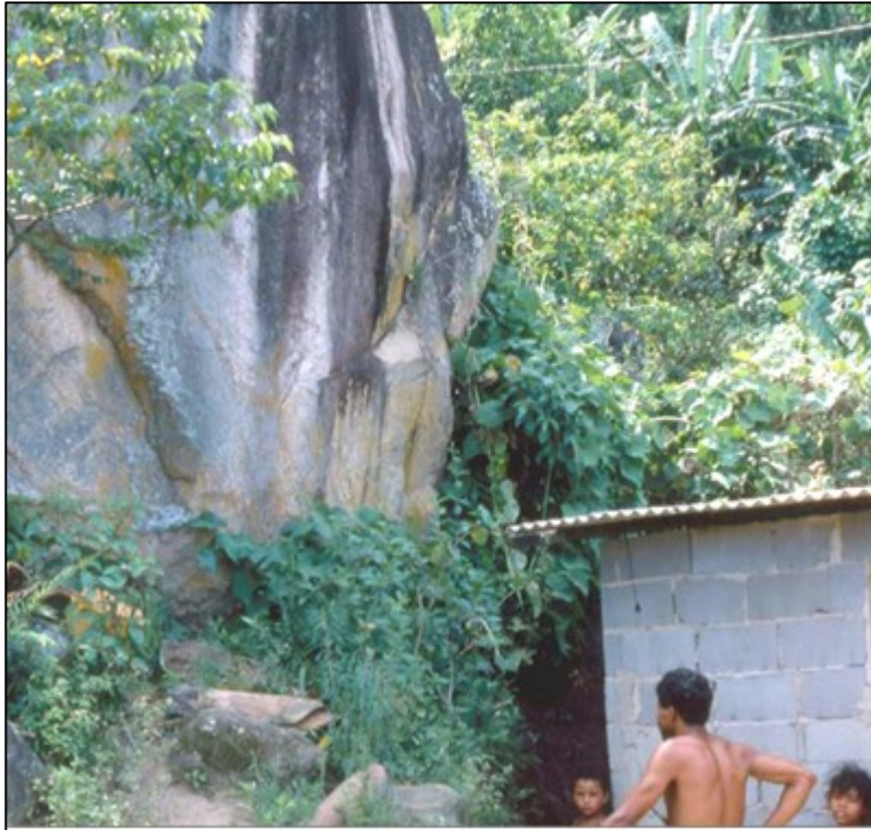
Figura 3 – Situação de risco de tombamento de bloco rochoso.
