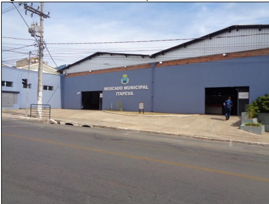
Figura 25 – Vista do Mercado Municipal. Notar as bocas de lobo.
